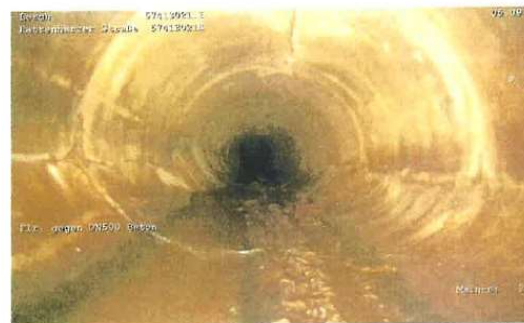
Rohrbruch / Rohrdeformation:
